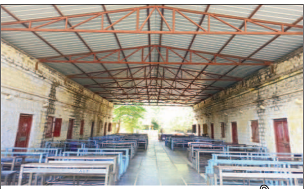
పాత హోటల్ భవనాల ముందు నూతనంగా నిర్మించిన పెడిను తరగతి గదిగా మార్చిన దృశ్యం
